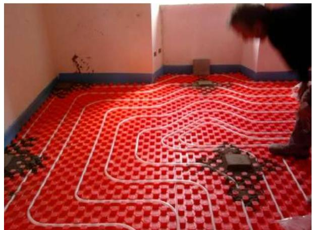
**Ristrutturazione completa appartamento privato con demolizioni e ricostruzioni, nelle foto vari particolari dell'appartamento della torretta esterno terrazzo e particolare dell'impianto di riscaldamento a pavimento.**
